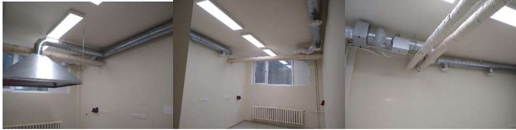
Част от помещение А004 след извършения ремонт
