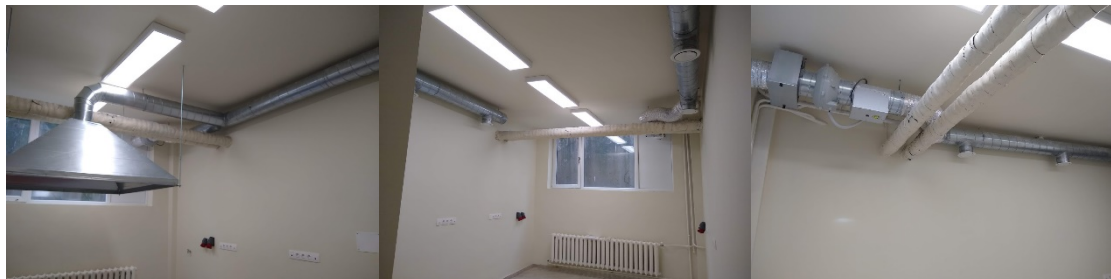
Фигура 2: Части от помещение А004 след извършения ремонт.
