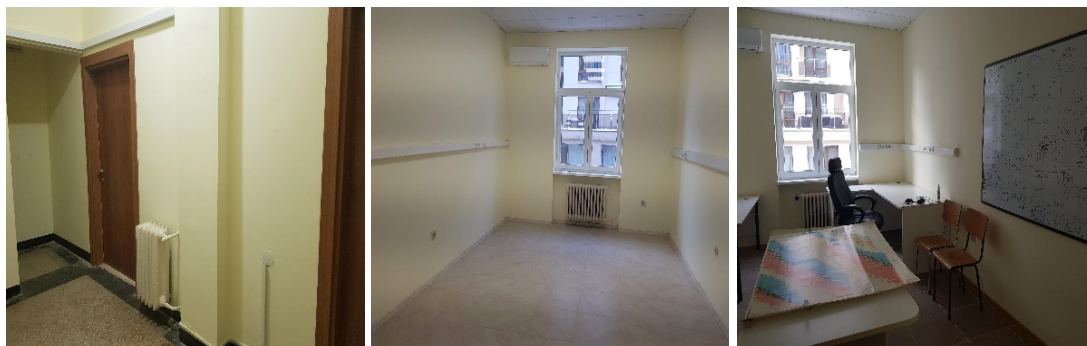
Фигура 3: Помещения Б25 след извършения ремонт.
